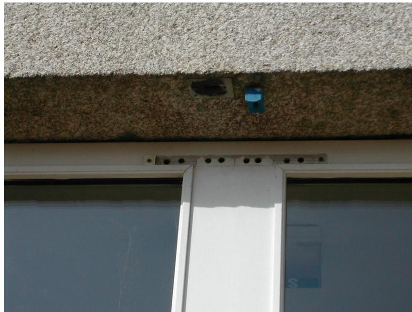
*Entrées d'air bouchées par des insectes et non conforme!*
