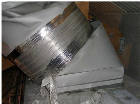
*Raccordement des conduits et accessoires du réseau aéraulique non étanche à l'air*
